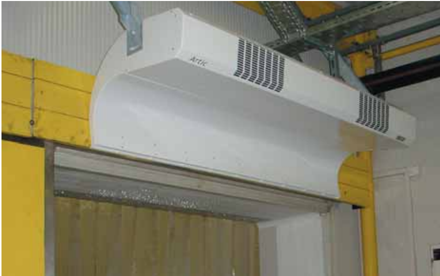
Slika 1. Montirana u prostoru zračna zavjesa Artic
